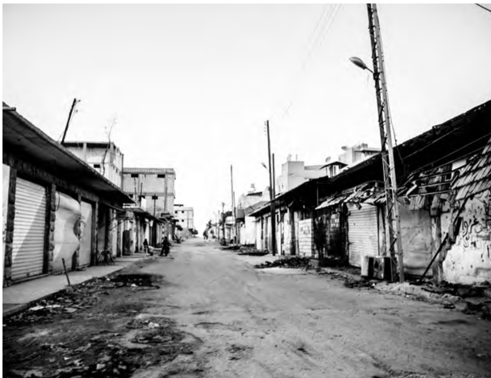
Blick auf eine zerstörte Straße in Ras al Ayn.
